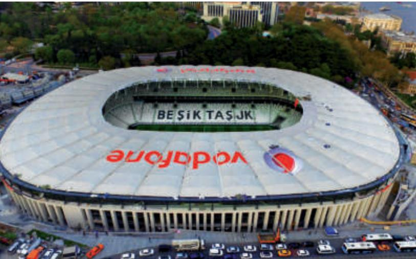
Hochfeste Stahlseile ermöglichen imposante und leichte Dachkonstruktionen für Stadien und Veranstaltungshallen mit minimalem Materialeinsatz. Dabei haben flexible Seile Vorteile gegenüber starren Strukturen.
