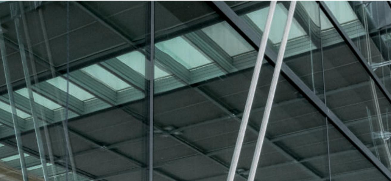
Der Flughafen Berlin Brandenburg International (BBI) wurde für eine jährliche Kapazität von 40 Millionen Passagieren gebaut. Die rund 340 Meter langen Glassfassaden wurden mit HYEND-Gabelköpfen und 4'800 Meter offenen Spiralseilen aus nichtrostendem Stahl mit 20 und 30mm Durchmesser abgespannt.
