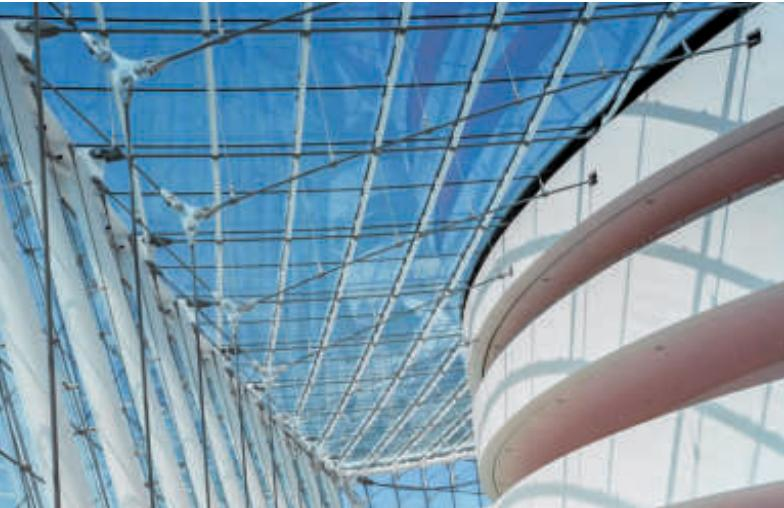
Leichte und modern gestaltete Seilbauprojekte sind die Fundamente zukünftiger Gebäude. Hochfeste Stahldrahtseile von FATZER erweitern die kreativen Möglichkeiten. Ihre Flexibilität erleichtert die Montage und reduziert das Gewicht der Konstruktion signifikant. Durchdachte Konstruktionsdetails betonen das Erscheinungsbild der Konstruktion.
