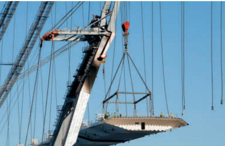
Konfektionierte offene und vollverschlossene Spiralseile blicken auf eine erfolgreiche und beeindruckende Anwendungshistorie in Strassen- und Eisenbahnbrücken zurück. Mit ihnen lassen sich grosse Spannweiten in kurzer Zeit realisieren, da sie einbaufertig vor Ort ankommen.
