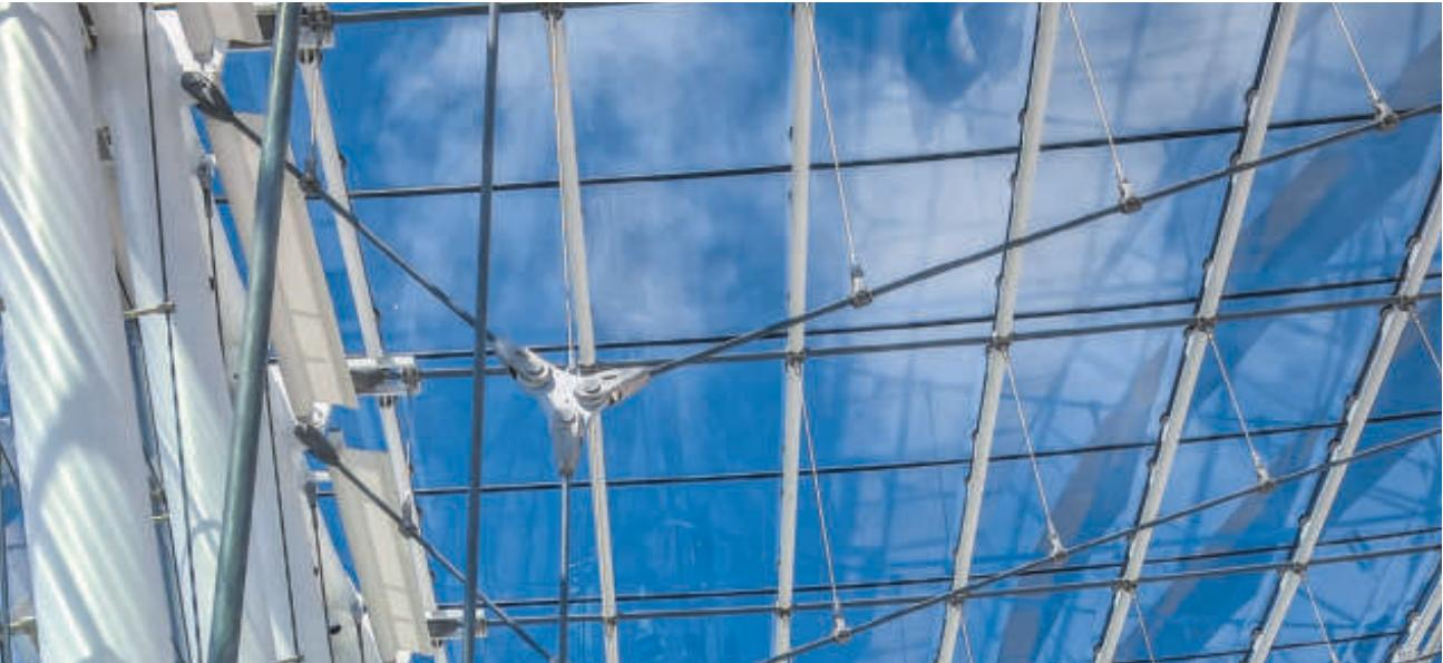
Das Kauffman Center for Performing Arts in Kansas City zählt zu den einzigartigen und ikonenhaften Gebäuden. Das 110 Meter lange Glasdach sowie die Glaswand mit ihren 27 Stahlträgern sind mit nahezu 5'000 Metern Stahldrahtseil abgespannt. Für dieses Projekt wurden mehr als 100 vollverschlossene (VVS) mit Durchmessern von 40 bis 95mm sowie 200 offene Spiralseile (OSS) mit Durchmessern bis 32mm verbaut.
