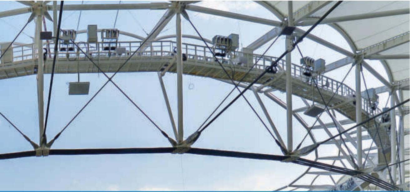
FATZER produzierte rund 5.1 Kilometer offene Spiralseile (OSS) sowie vollverschlossene Stahlseile (VVS) mit Durchmessern von 20 bis 110mm und 420 Vergusshülsen. Die Seile wurden den technischen Anforderungen der führenden Seilbau-Ingenieure entsprechend produziert und konfektioniert sowie von unabhängigen Prüfanstalten kontrolliert.
