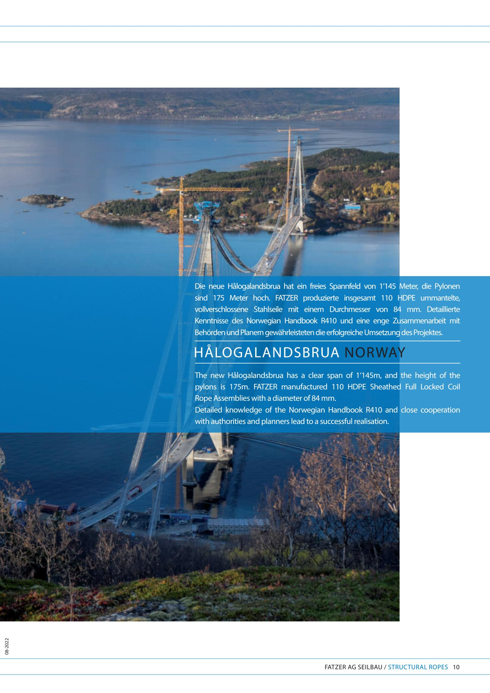
Die neue Hålogalandsbrua hat ein freies Spannfeld von 1'145 Meter, die Pylonen sind 175 Meter hoch. FATZER produzierte insgesamt 110 HDPE ummantelte, vollverschlossene Stahlseile mit einem Durchmesser von 84 mm. Detaillierte Kenntnisse des Norwegian Handbook R410 und eine enge Zusammenarbeit mit Behörden und Planern gewährleisteten die erfolgreiche Umsetzung des Projektes.
