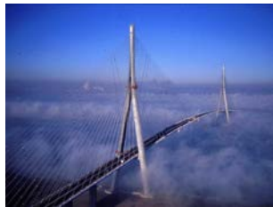
Pont de Normandie, France
