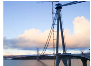
Hålogaland Bridge, Norway
