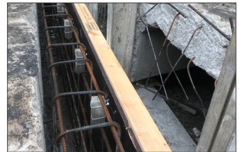
RebaGuard anodes in position ahead of concrete pour
